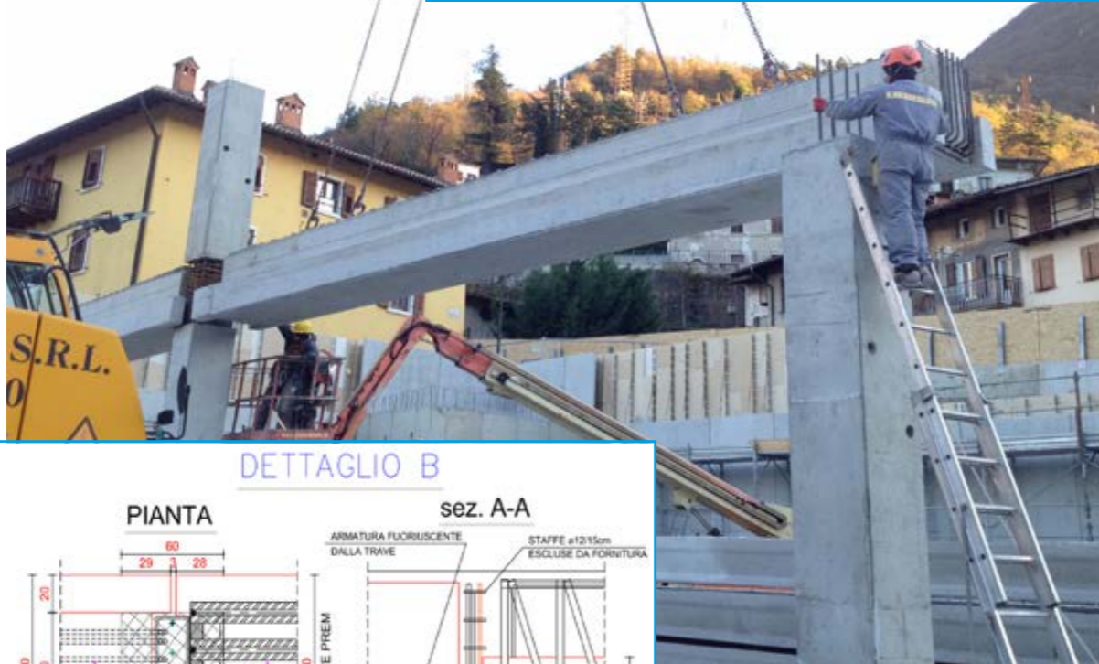
Continuità travi c.a.p reticolare
