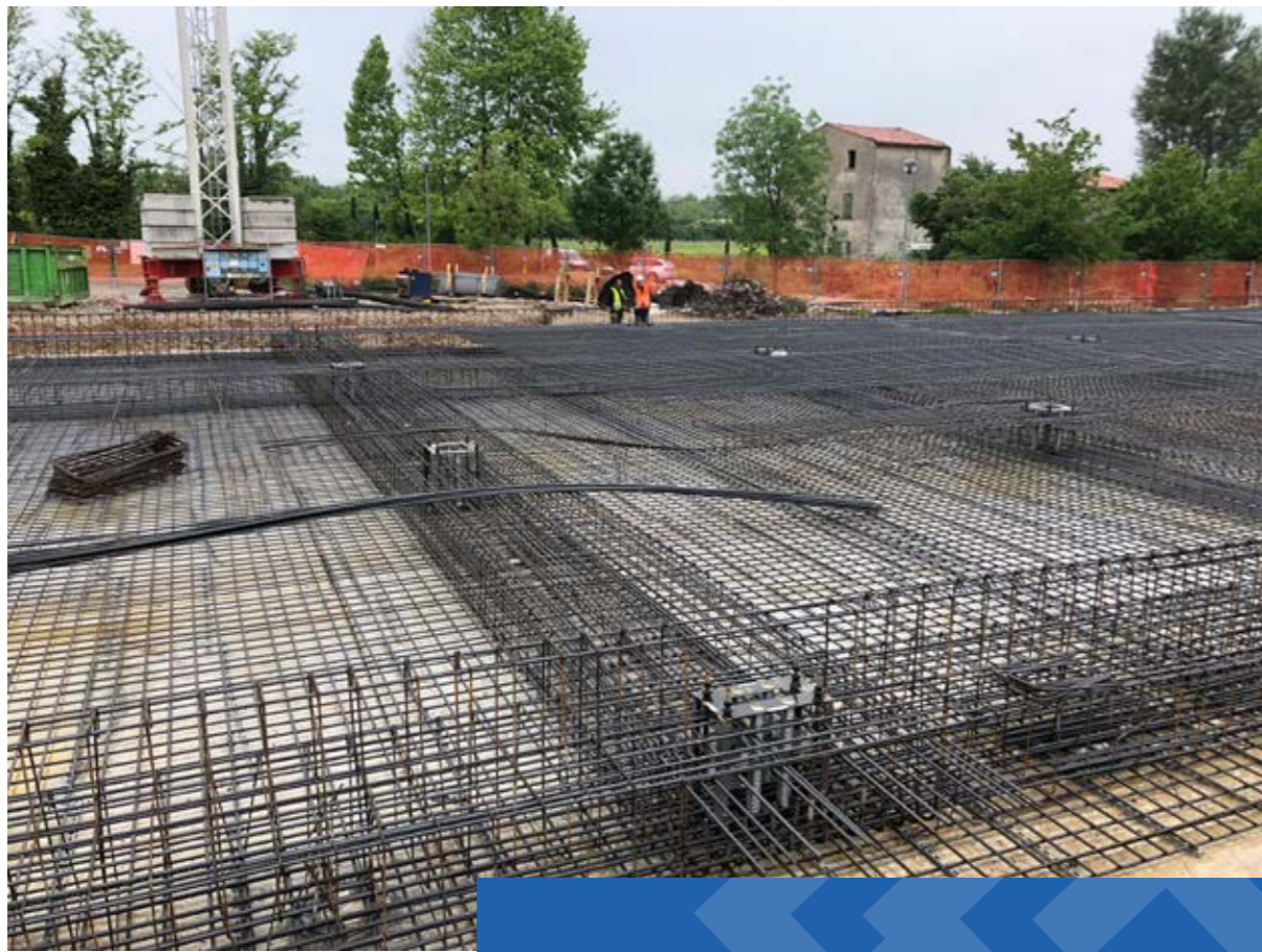
(AIM) Connessione in fondazione
