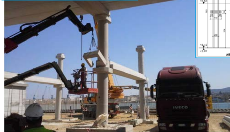
Pilastro cilindrico con collare pluripiano
