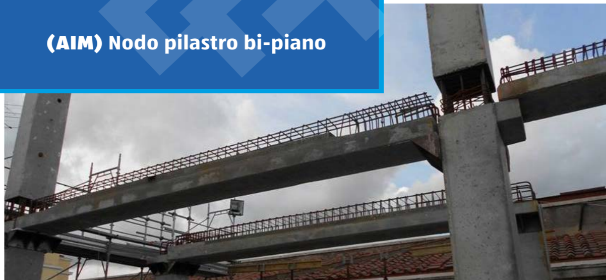
Continuità travi c.a.p reticolare
