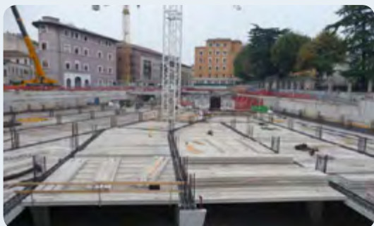
Impr. Astaldi S.p.A. – Sub. Impr. Soveco S.p.A. Quadratura: 14.000 mq
