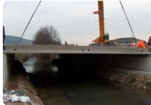
STRUTTURA SOTTOPASSI VIABILITA'
