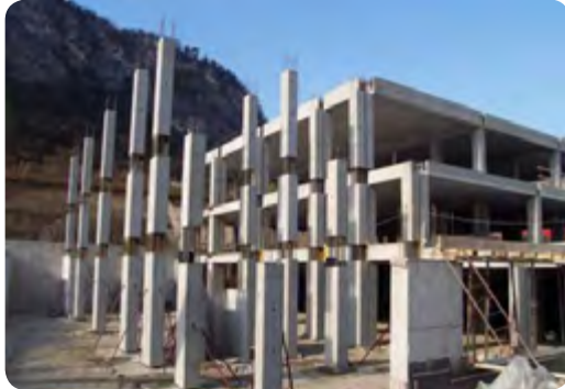
SISTEMA CON TRAVI IN C.A. / C.A.P.
