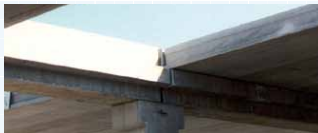
Lastra alveolare appoggiata su trave prefabbricata.
