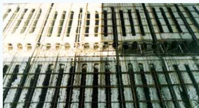
Testata predisposta per il getto di un'ala collaborante estesa.
