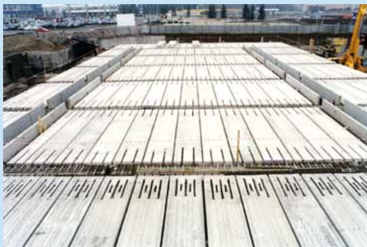
Lastre alveolari con fresature alle testate.
