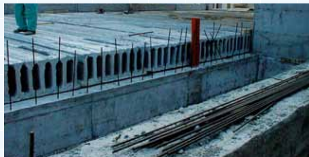
Nodo muro portante-solaio nel caso di appoggio.
