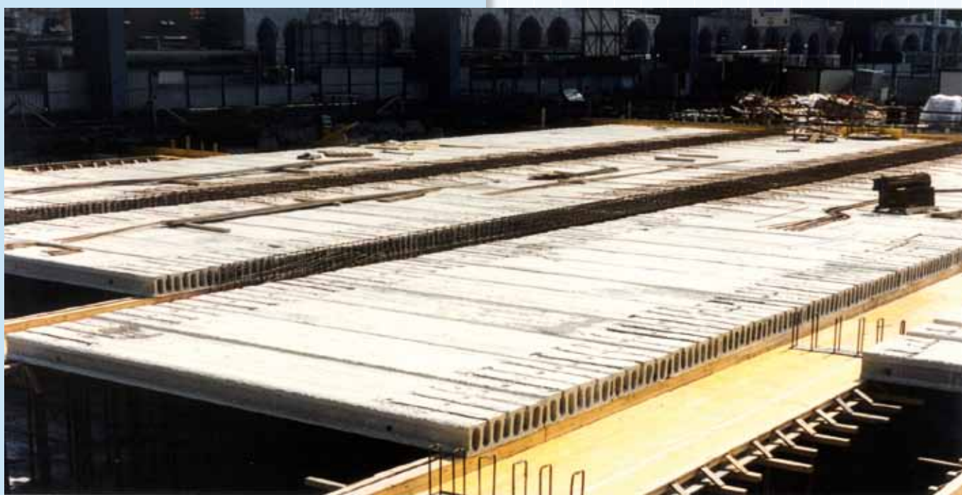
Lastre alveolari posate in opera con fresature e testate predisposte per l'alloggiamento delle armature di collegamento in luce netta.
