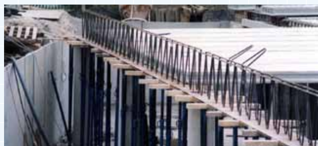
Nodo parete in muratura-solaio.
